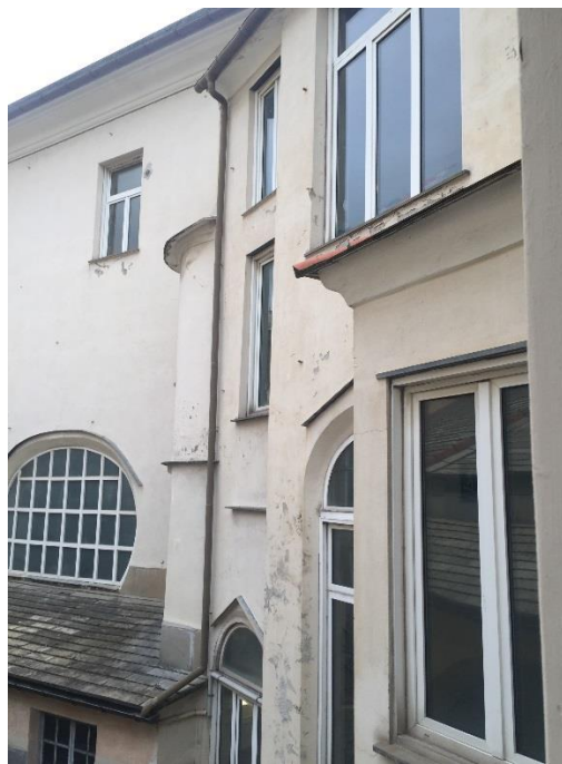
Figura 1.1 - Vista della facciata esposta a Nord
