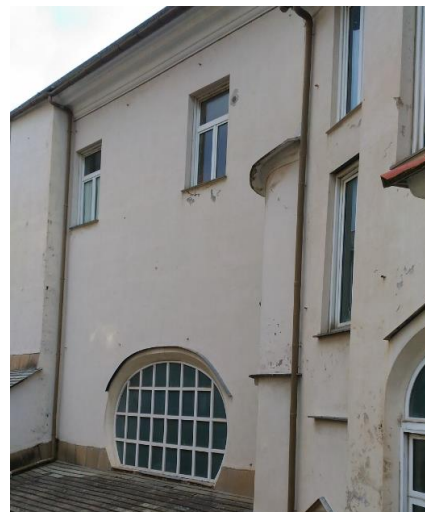
Figura 4.1 - Particolare della porzione di involucro esposta a Nord
